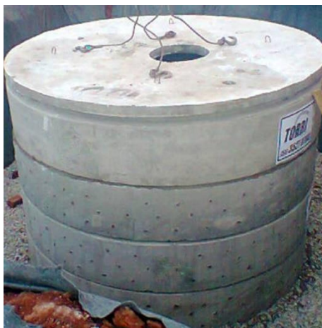
Imagem 01: referência para execução de sumidouro pré-moldado com tampa de concreto armado.
